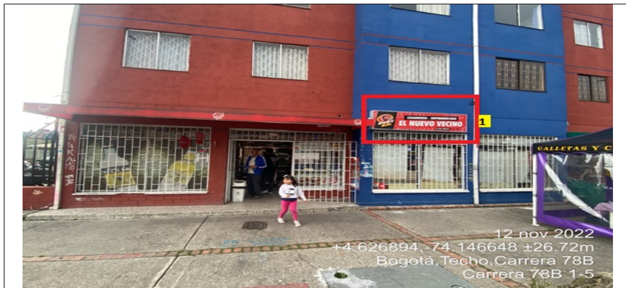
En la cual se evidencia un elemento tipo aviso en fachada perteneciente al establecimiento comercial denominado CIGARRERÍA Y SUPERMERCADO EL NUEVO VECINO , el cual al momento de la visita se encontraba instalado sin el registro ante la SDA.
